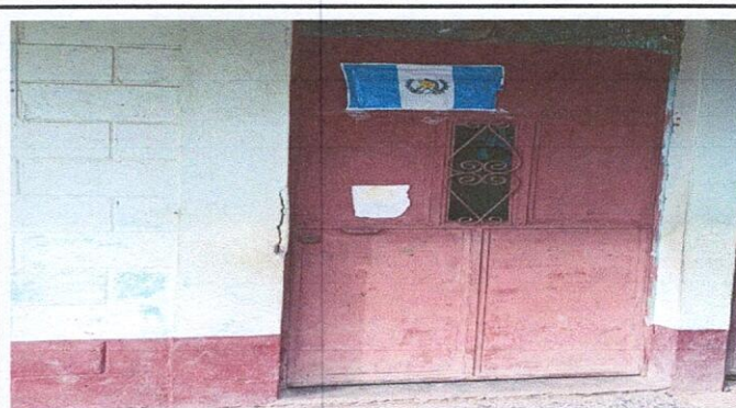
Foto 2: MÓDULO 1 MANTENIMIENTO DE PUERTAS DE METAL DE 98 CMS DE ANCHO POR 2.10 DE ALTO
