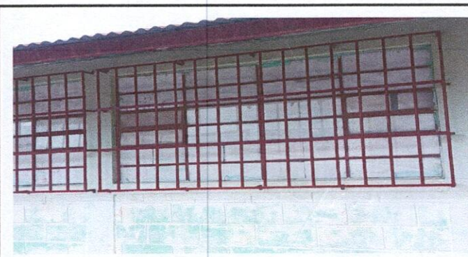
Foto 6: MÓDULO 2 MANTENIMIENTO DE BALCONES DE METAL DE 2.35 CMS DE ANCHO POR 1.30 DE ALTO.
