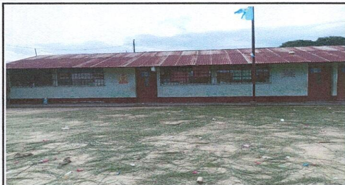
Foto1: MÓDULO 1: SUSTITUCION DE LAMINA, POR LAMINA TROQUELADA.
