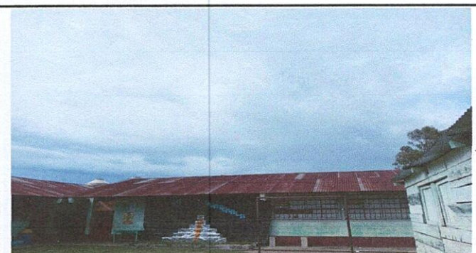
Foto 4: MÓDULO 2 SUSTITUCION DE LAMINA, POR LAMINA TROQUELADA.
