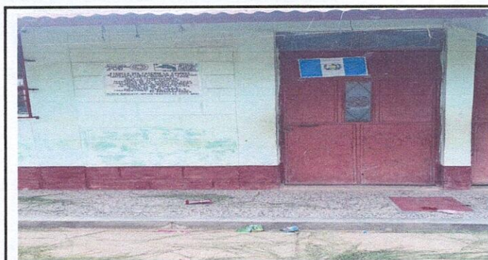
Foto 5: MÓDULO 2 MANTENIMIENTO DE PUERTAS DE METAL DE 98 CMS DE ANCHO POR 2.10 DE ALTO.
