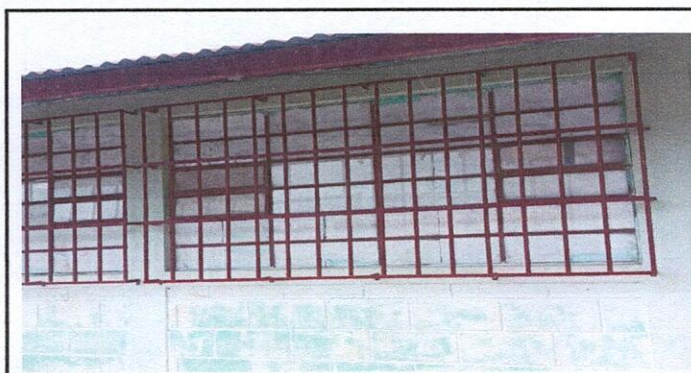
Foto 3: MÓDULO 1 MANTENIMIENTO DE BALCONES DE METAL DE 2.35 CMS DE ANCHO POR 1.30 DE ALTO
