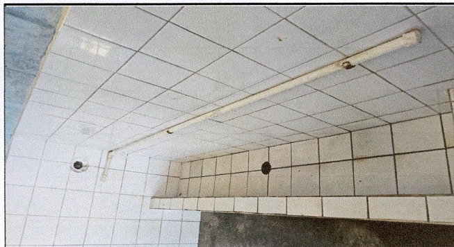
Foto 1: Sustitución de llaves de mingitorios
