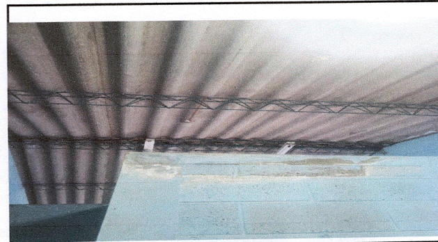
Foto 6: Mantenimiento de estructura portante.
