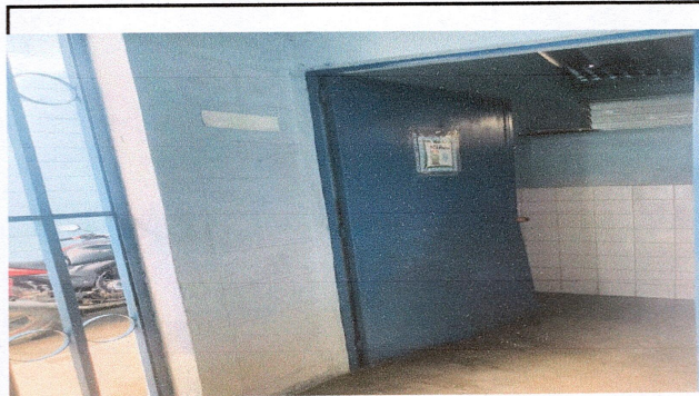
Foto 4: Sustitución de puertas
