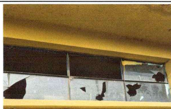
Foto 4: Sustitución de vidrios de ventanas
