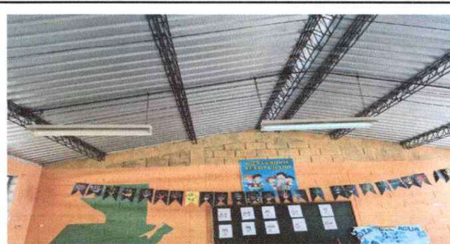
Foto 6: Sustitución de lámparas
