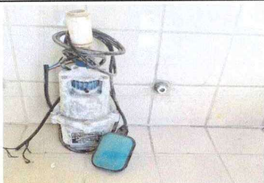
Foto 7: Sustitución de bomba de agua
