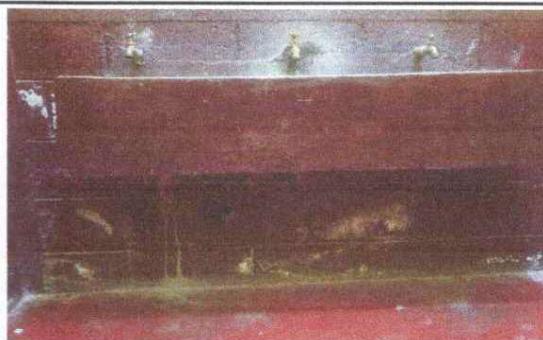
Mejoramiento en baños
