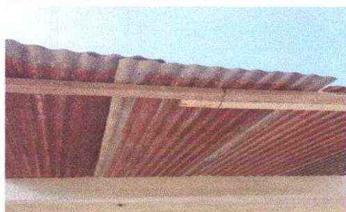
Sustitución de lámina por lámina troquelada calibre 26 de 9 pies
