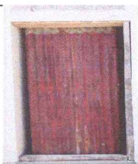
Sustitución de puertas de madera por puertas de metal
