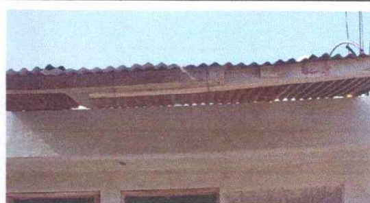
Sustitución de estructura portante de madera por metal
