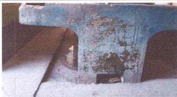
Sustitución de pilas
