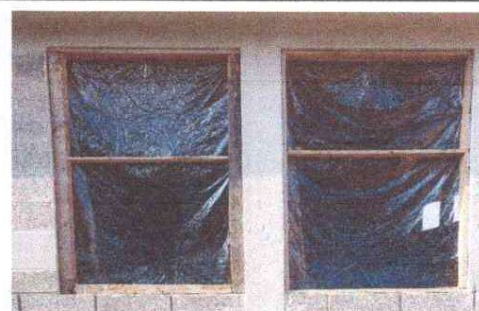
Sustitución de ventanas de madera por ventanas de metal
