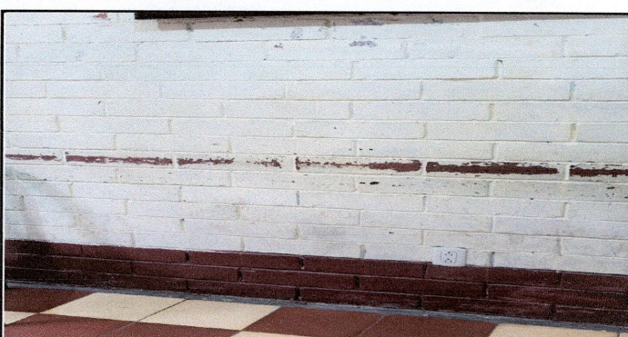
Foto 6: Pintura de muros interiores y exteriores
