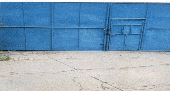
Foto 5: Sustrucción de portón de ingreso
