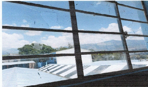
Foto 2: SUSTITUCIÓN DE VENTANAS
