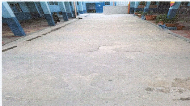
Foto 7: MEJORAMIENTO DE PISO ENTRADA PRINCIPAL
