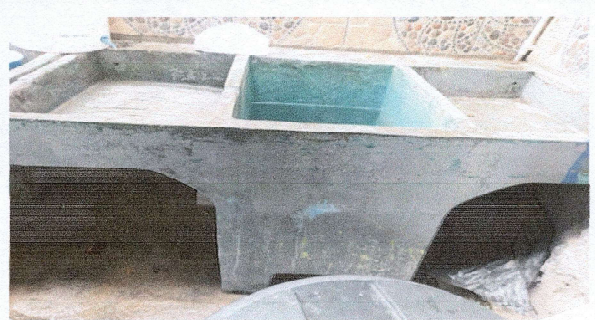
Foto 8: SUSTITUCIÓN DE PILAS
