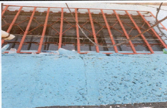
Foto 3: SUSTITUCIÓN DE BALCONES
