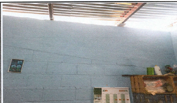
Foto 4: MEJORAMIENTO Y REPARACIÓN DE TECHO DIRECCIÓN
