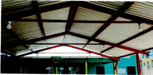
Foto 7: se mejoró el cableado electrico de ambos patios
