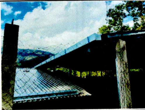
Foto 3: se mejoraron los canales de metal en diferentes areas
