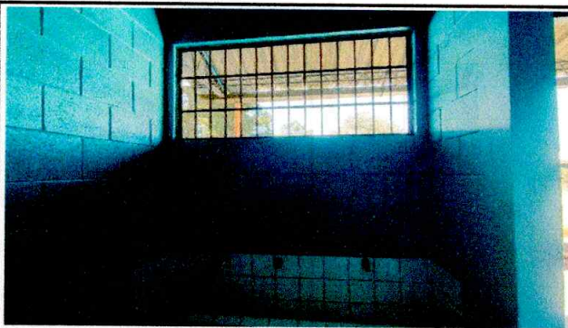
Foto 11: se mejoró la pintura de area de baños
