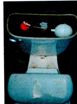
Foto 4: se sustituyeron los accesorios de todos los baños
