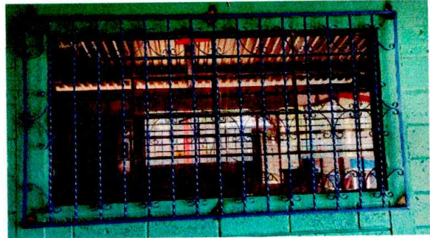
Foto 2: se mejoraron los balcones de las ventanas
