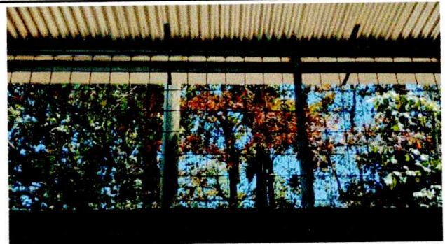
Foto 6: se mejor el muro perimetral con electromalla
