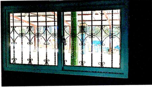
Foto1: Se sustituyó las ventanas de madera por ventanas de PVC y vidrio
