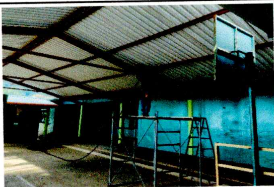
Foto 3: se esta mejorando los canales de metal en diferentes areas
