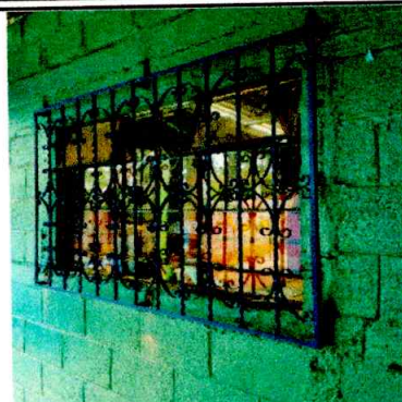
Foto 2: se estan mejorando los balcones de ventanas
