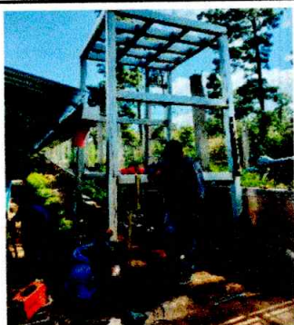
Foto 9: se esta sustituyendo la base y el deposito de agua potable
