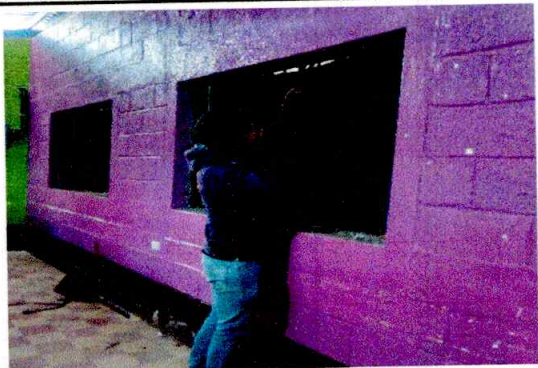
Foto1: Se esta sustituyendo las ventanas de madera por ventanas de PVC y vidrio
