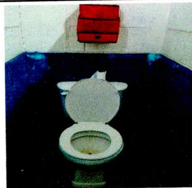
Foto 4: se esta sustituyendo los accesorios de todos los baños
