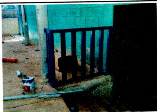
Foto 5: se estan mejorando las barandas de metal en dos laterales
