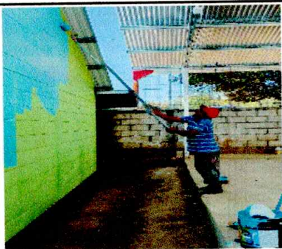
Foto 11: se esta mejorando la pintura de area de baños
