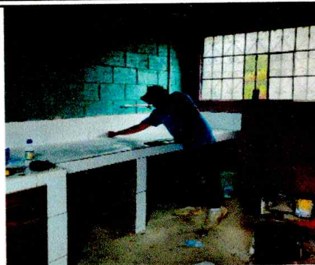
Foto 8: se esta sustituyendo mesa de madera por mesa de concreto con azulejo
