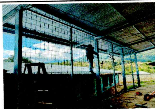
Foto 6: se esta mejorando los muros perimetrales con electromalla
