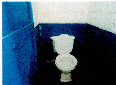
Foto 4: Se sustituir los accesorio de todos los baños
