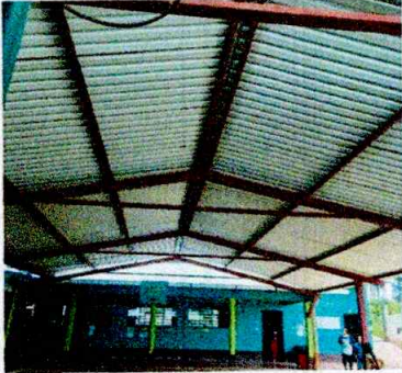
Foto7: Mejoramiento de cableado eléctrico
