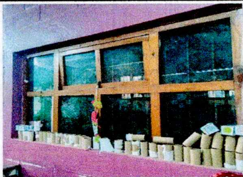
Foto 1: Se sustituir las ventanas de madera por ventanas de PVC y vidrio
