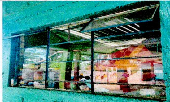
Foto 2: Mejoramiento de balcones de ventanas
