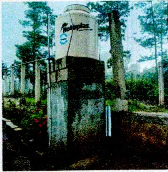
Foto9: Sustitución de deposito de agua
