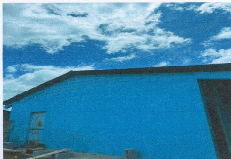
Foto 3: Mejoramiento de canal de metal y bajadas de agua pluvial.
