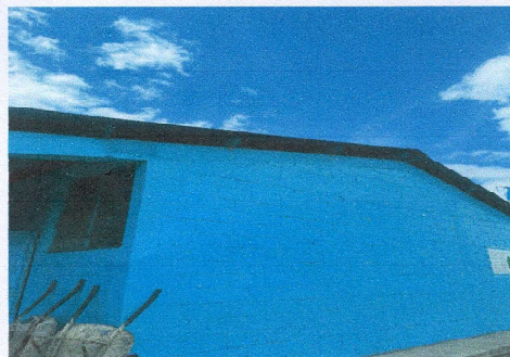
Foto 2: Sustrucción de lámina ondulada a lámina troquelada.
