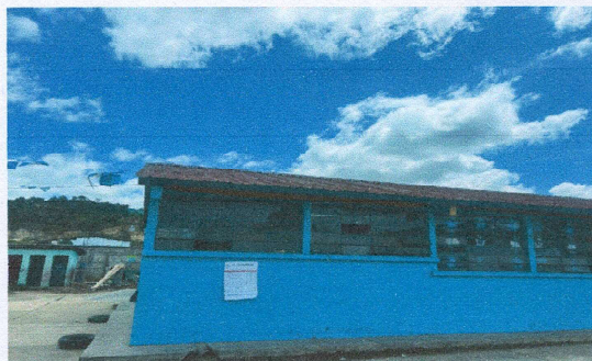
Foto 4: Mejoramiento de canal de metal.
