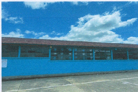
Foto1: Sustrucción de lámina ondulada a lámina troquelada.
