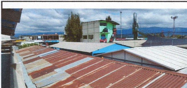
FOTO 1. SUSTITUCIÓN DE LÁMINA, POR LÁMINA TROQUELADA ALUZINC CALIBRE 26
