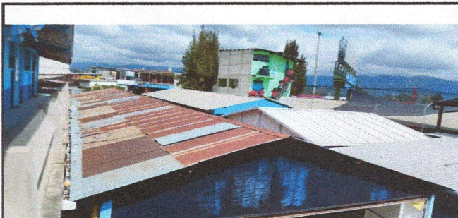
FOTO 2. SUSTITUCIÓN DE CAPOTE DE LÁMINA PARA LÁMINA TROQUELADA
