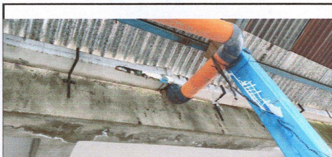
FOTO 5. REPARACIÓN DE BAJADA DE AGUA PLUVIAL, TUBO PVC 3"
