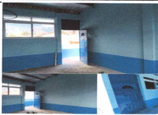
Foto 14: Mejoramiento de puertas de metal en aulas modulo 3 (115 X 270 cm)
