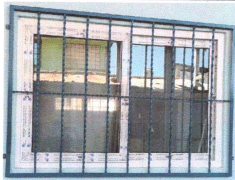
Foto1: Sustitución de ventanas de metal por UPVC en aulas modulo 1 (149.5 X 99.5 cm)
