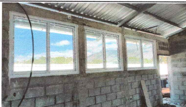
Foto 3: Mejoramiento de ventanas de UPVC, en aulas modulo 2 (120 X 120 cm)
