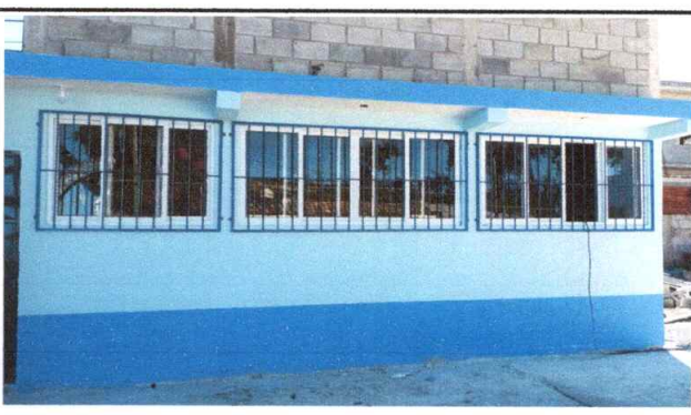
Foto 10: Mejoramiento de Balcones de metal, en cocina modulo 2 (240 X 130 cm )
