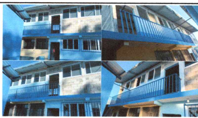
Foto 16: Mejoramiento de baranda de metal, en modulo 2 (750 X 100 cm )
