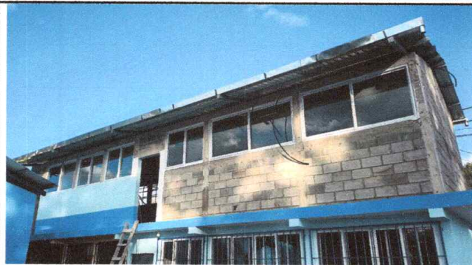
Foto13: Mejoramiento de canal pluvial de lamina lisa calibre 26
