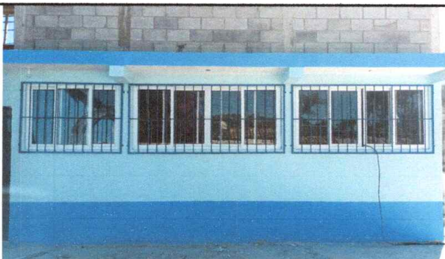
Foto 9: Mejoramiento de Balcones de metal, en cocina modulo 2 (260 X 130 cm )
