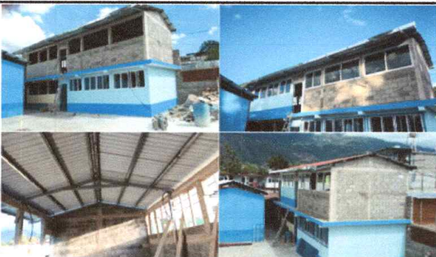
Foto 11: Mejoramiento de lamina troquelada calibre 26, en aulas segundo nivel modulo 2
