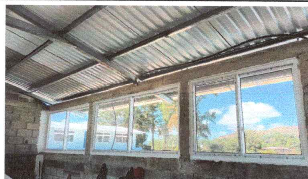
Foto 4: Mejoramiento de ventanas de UPVC, en aulas modulo 2 (146 X 120 cm)
