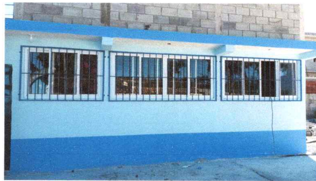
Foto 8: Mejoramiento de Balcones de metal, en cocina modulo 2 (154 X 130 cm )
