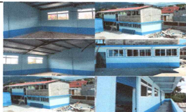
Foto 17: Mejoramiento de repello de paredes exteriores e interiores, en aulas modulo 2 y 3
