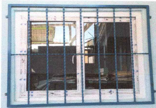
Foto 2: Sustitución de ventanas de metal por UPVC, cm en aulas modulo 1 (118 X 99.5 cm)
