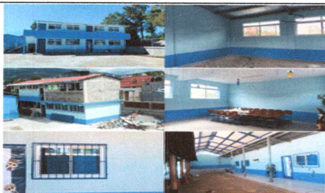
Foto 15: Pintura en muros exteriores e interiores modulo 1, 2 y 3
