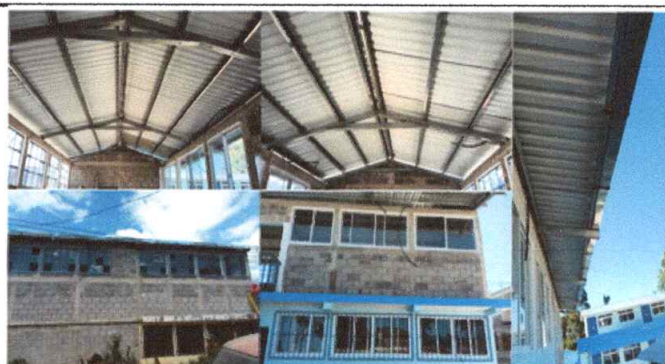
Foto 12: Mejoramiento de estructura portante metalica, en aulas segundo nivel modulo 2
