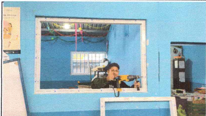
Foto 1: Sustitución de ventanas de metal por UPVC en aulas modulo 1 (149.5 X 99.5 cm)
