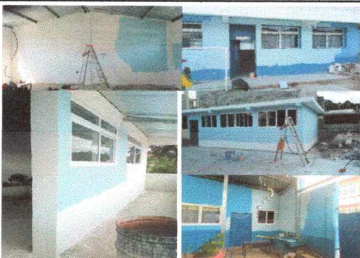
Foto 15: Pintura en muros exteriores e interiores modulo 1, 2 y 3
