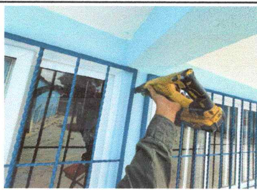
Foto 10: Mejoramiento de Balcones de metal, en cocina modulo 2 (240 X 130 cm )
