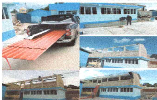
Foto 11: Mejoramiento de lamina troquelada calibre 26, en aulas segundo nivel modulo 2
