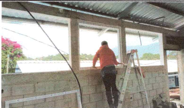
Foto7: Mejoramiento de ventanas de UPVC, en aulas modulo 2 (240 X 120 cm)
