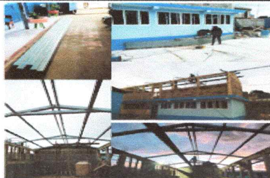
Foto 12: Mejoramiento de estructura portante metalica, en aulas segundo nivel modulo 2
