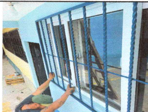
Foto 8: Mejoramiento de Balcones de metal, en cocina modulo 2 (154 X 130 cm )
