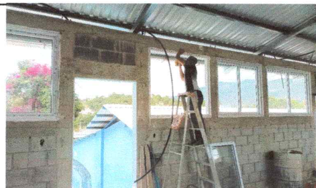
Foto 4: Mejoramiento de ventanas de UPVC, en aulas modulo 2 (146 X 120 cm)
