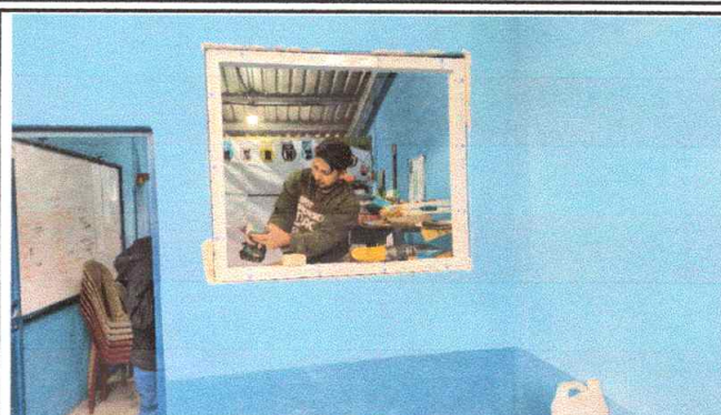
Foto 2: Sustitución de ventanas de metal por UPVC, cm en aulas modulo 1 (118 X 99.5 cm)
