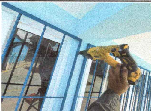
Foto 9: Mejoramiento de Balcones de metal, en cocina modulo 2 (260 X 130 cm )
