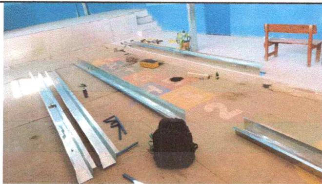
Foto 13: Mejoramiento de canal pluvial de lamina lisa calibre 26
