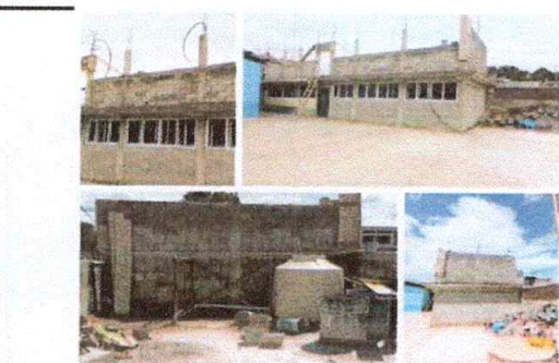
Foto 11: Mejoramiento de lamina troquelada calibre 26, en aulas segundo nivel módulo 2
