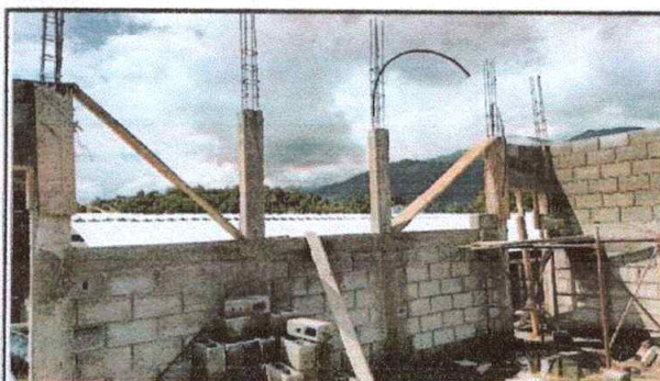
Foto 4: Mejoramiento de ventanas de UPVC, en aulas módulo 2 (146 X 120 cm)
