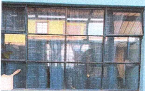
Foto1: Sustrución de ventanas de metal por UPVC en aulas módulo 1 (149.5 X 99.5 cm)
