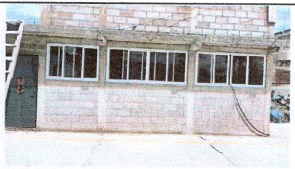
Foto 9: Mejoramiento de Balcones de metal, en cocina módulo 2 (260 X 130 cm )
