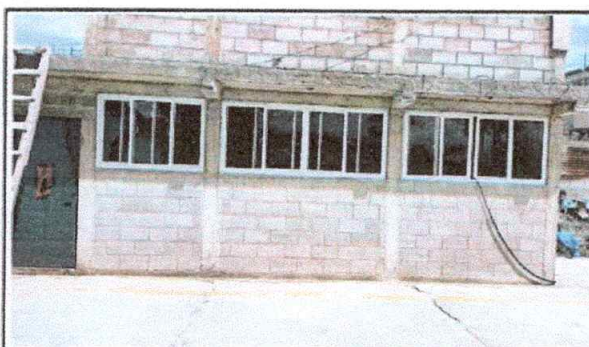
Foto 10: Mejoramiento de Balcones de metal, en cocina módulo 2 (240 X 130 cm )
