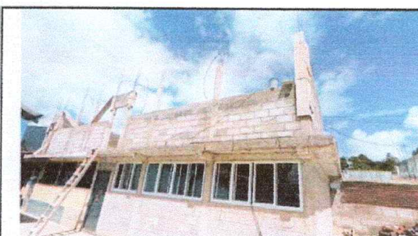
Foto 6: Mejoramiento de ventanas de UPVC, en aulas módulo 2 (260 X 120 cm)
