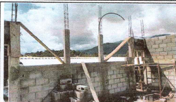
Foto 7: Mejoramiento de ventanas de UPVC, en aulas módulo 2 (240 X 120 cm)
