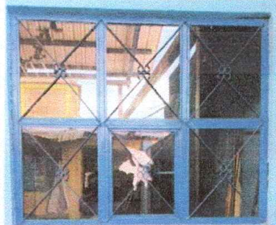
Foto 2: Sustrución de ventanas de metal por UPVC, cm en aulas módulo 1 (118 X 99.5 cm)
