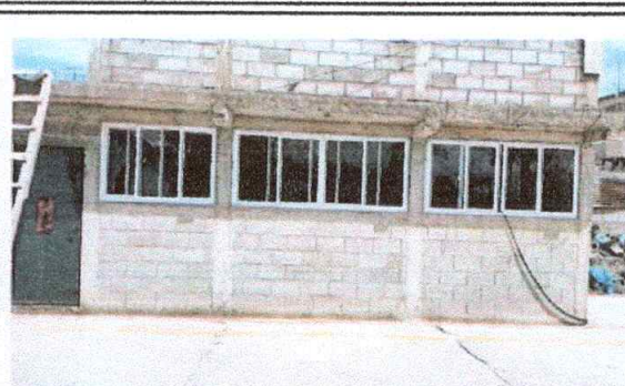
Foto 8: Mejoramiento de Balcones de metal, en cocina módulo 2 (154 X 130 cm )
