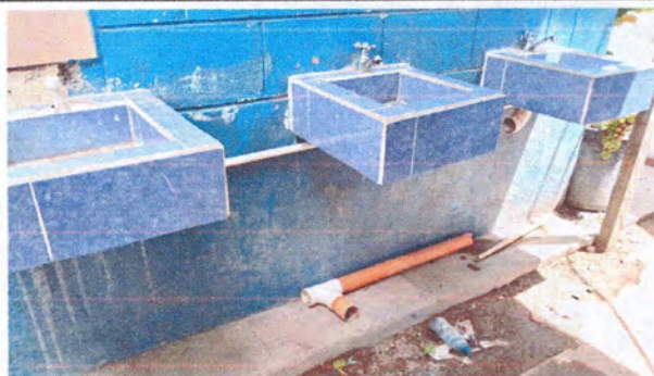
Foto : Sustrucción de tubería de drenaje
