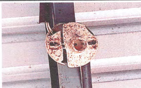
Foto 10: Sustitución de plafoneras
