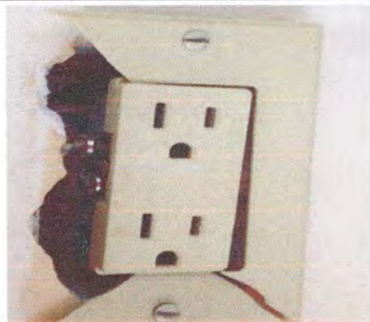
Foto 14: Sustrucción de tomacorrientes
