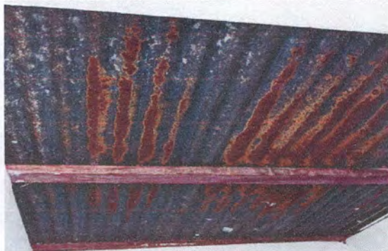
Foto1: Sustitución de lamina troquelada de 10 pies.
