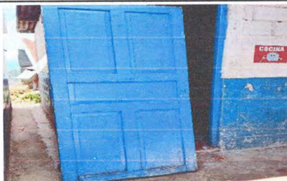
Foto 4: Sustitución de puerta de cocina de 1x 2.10 mts.
