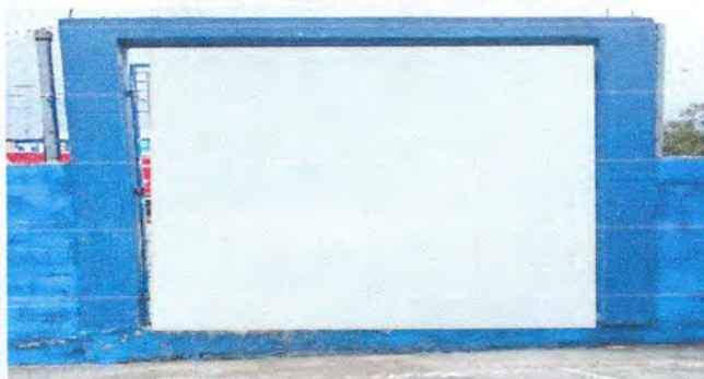
Foto 6: Sustitución de estructura portante
