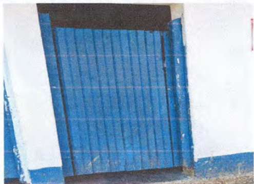
Foto 7: Sustitución de puertas de servicios sanitarios
