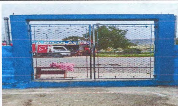
Foto 3: Sustitución de portón principal de 3x210 mts.
