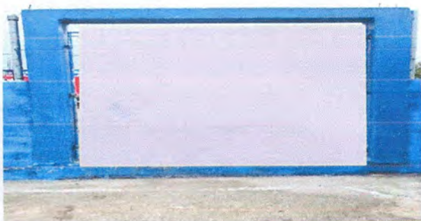
Foto 5: Mantenimiento de estructura portante
