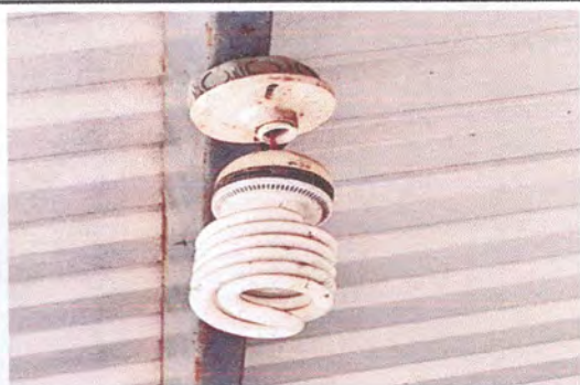
Foto 11: Sustitución de focos
