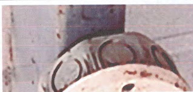
Foto 12: Sustitución de cajas octagonales
