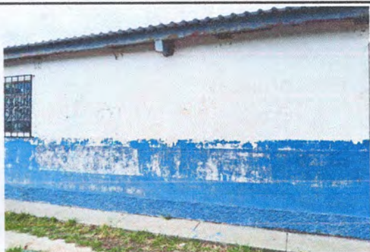
Foto 9: Pintura en muros exteriores
