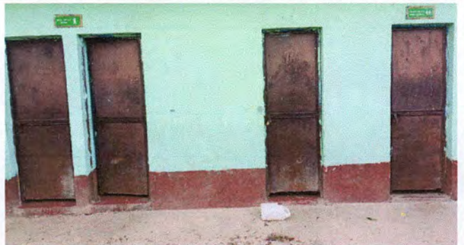
Foto 10: Mejoramiento y reparación de puertas de metal en baños, 80 cms ancho por 1.80 mts alto
