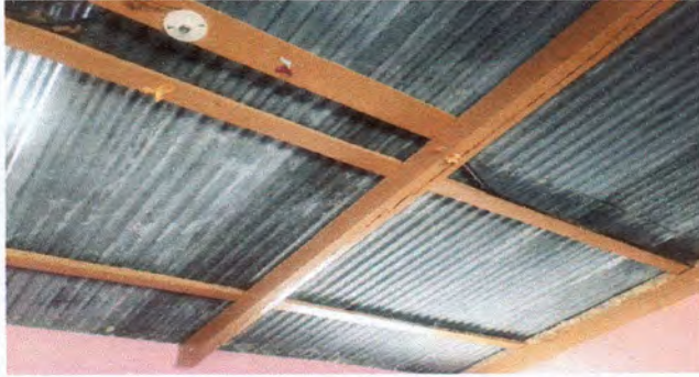
Foto1: Sustitución de estructura portante de madera por metálica, en aulas modulo 1
