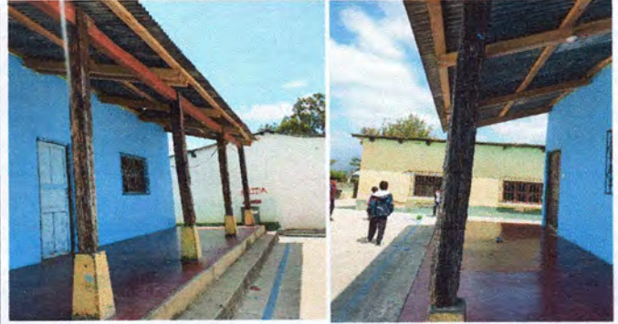
Foto 2: Sustitución de columnas de madera por estructura metálica en corredor de aulas modulo 1
