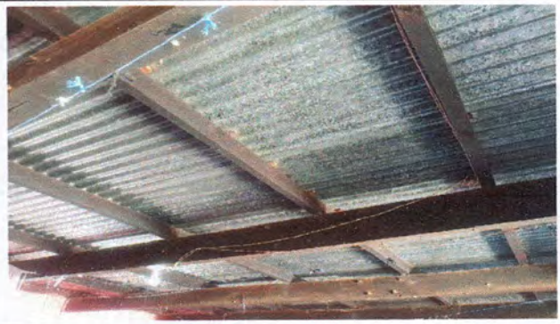
Foto 4: Mejoramiento de estructura portante de madera por metálica, en aulas modulo 3
