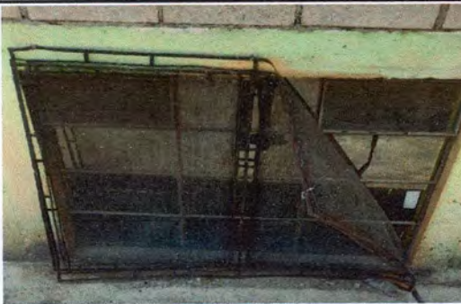
Foto 5: Sustitución de Balcón de metal en cocina.
