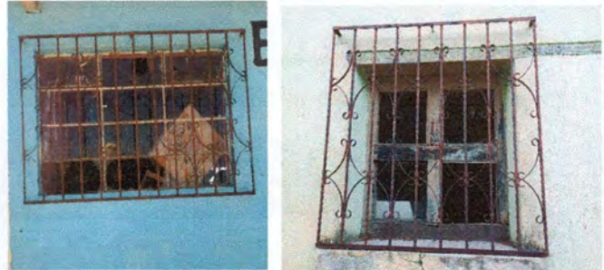
Foto 8: Mejoramiento y reparación de Balcones de metal
