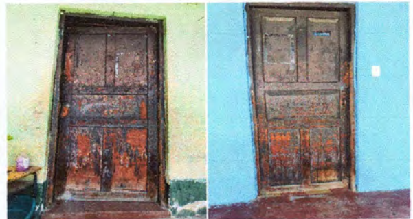
Foto 6: Sustitución de puerta de madera por metálica 1 metro de ancho por 220 metros alto
