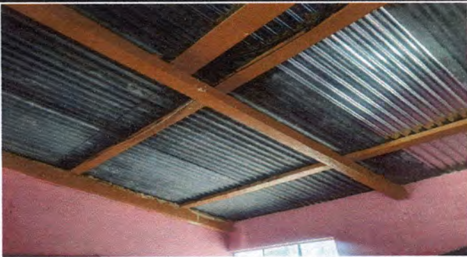
Foto 3: Sustitución de estructura portante de madera por metálica, en aulas modulo 2
