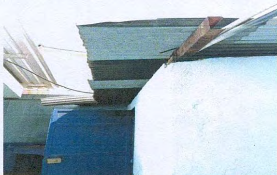
Foto 3: canales y bajadas de agua pluvial
