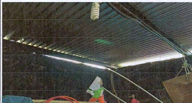
Foto 2: Estructura de techo
