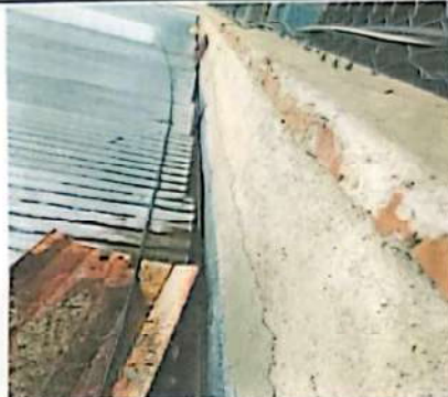
Foto 8: Canal de metal a sustituir
