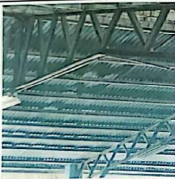
Foto 3: Estado actual de la estructura que sera intervenida.
