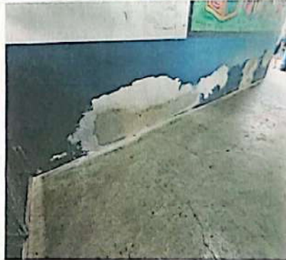
Foto 10: Área a intervenir con pintura en las paredes.
