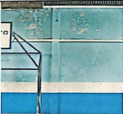
Foto 9: Pintura de paredes en el estado actual.
