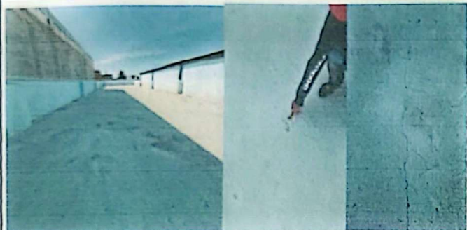
Foto 1: Losa segundo nivel ala norte con grietas visibles
