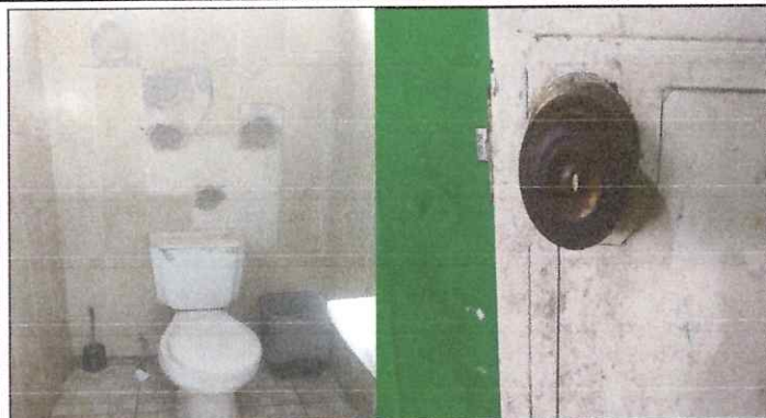
Foto: 1 Sustitución de sanitarios y chapas de puertas de baños
