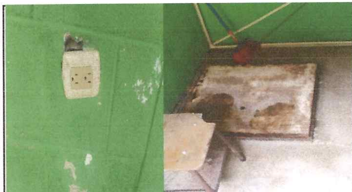
Foto: 3 Cambio de tomacorrientes y compuerta de cisterna subterránea
