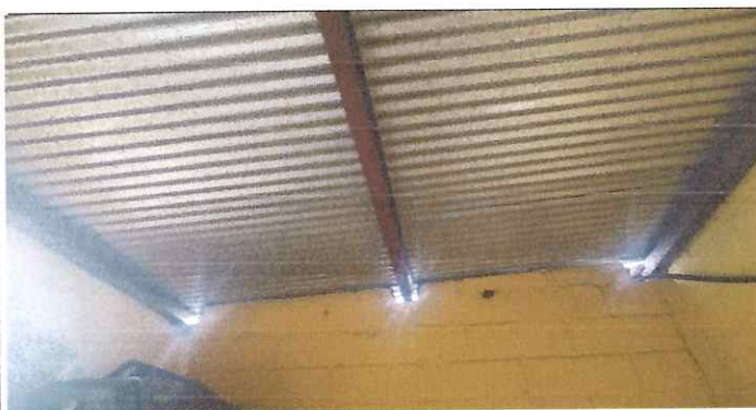
Foto: 5 Cambio de techo de cocina
