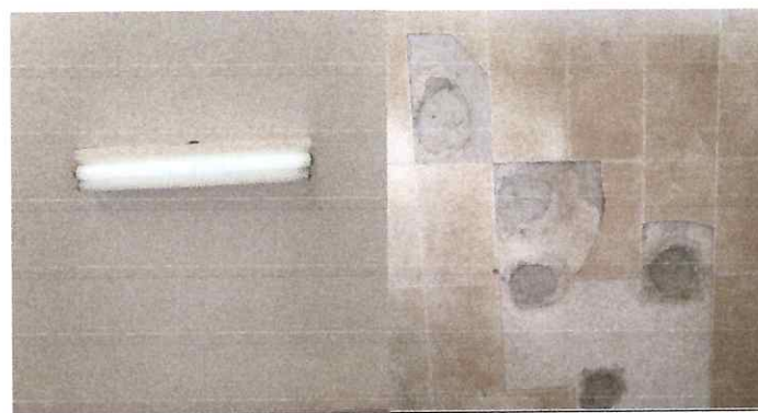
Foto: 6 Cambio de lámparas y lozas dañadas de sanitarios
