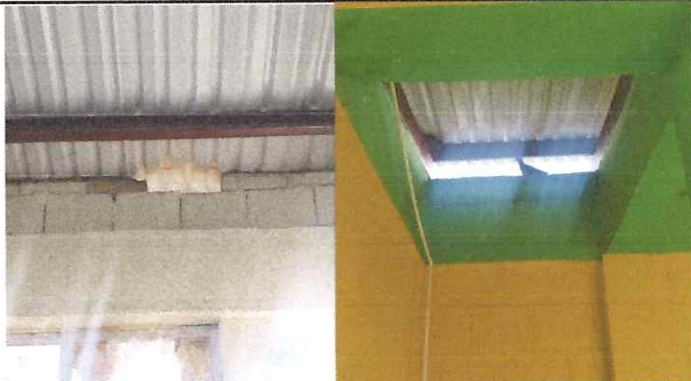
Foto: 2 Levantado de block para evitar acceso de palomas y polvo.
