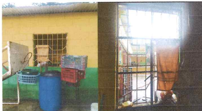
Foto: 4 Colocación de vidrios en ventanal de cocina
