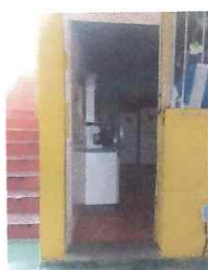
Foto 9: Instalación de ventana y balcon, puerta estilo reja para la cocina.
