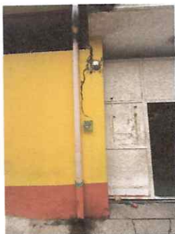
Foto: 1 Reforzamiento de pared.
