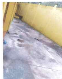
Foto 10: Pintura piso de patio.
