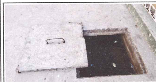
Foto: 5 CAMBIO DE TAPADERA DE CISTERNA
