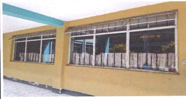
Foto: 4 MODIFICACION DE VENTANA FIJA A CORREDIZA EN SALONES DE CLASES
