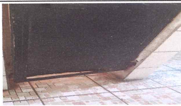
Foto: 2 CAMBIO DE PUERTAS DE SANITARIOS DE NIÑAS Y NIÑOS
