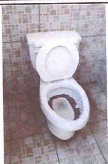
Foto: 1 Cambio de sanitarios por estar en mal estado. En aula 1,3,5,7,8
