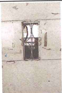
Foto: 3 Cambio de vidrio por lamina en portones de ingreso e Egreso del establecimiento.
