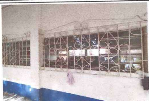
Foto: 1 Cambio de ventanas en todas las aulas por estar en mal estado y no habren.
