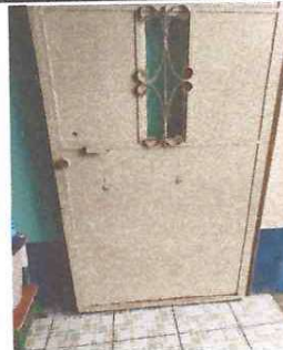
Foto: 4 Cambio de chapas delanteras de dos aulas y traseras en todas las aulas.
