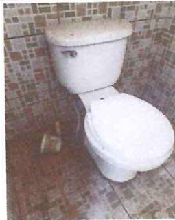
Foto: 2 Cambio de sanitarios por estar en mal estado. Cambio de sanitario en direccion.
