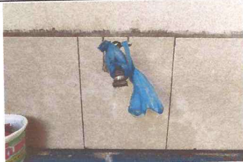
Foto: 2 Cambio de chorros en 8 aulas por mal estado.
