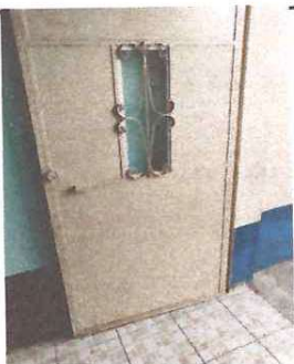
Foto: 3 Cambio de chapas en puertas traseras en todas las aulas
