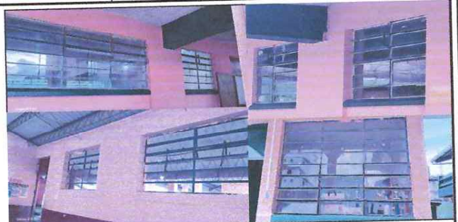
Foto: Cambio de ventanas a PVC
