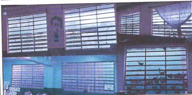
Foto: Mantenimiento de ventanas y cambio de vidrios
