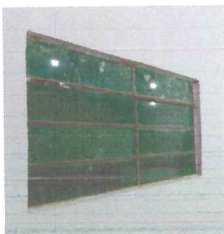
Foto: 3, sustitucion de 8 ventanas de metal a pvc corredizas. Y sustitucion de 8 balcones.
