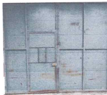
Foto: 2, Mantenimiento de porton principal entrada parte superior.
