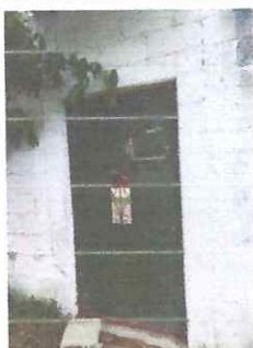
Foto: 5. Sustitucion de puerta por puerta de metal reforzada, parte posterior.
