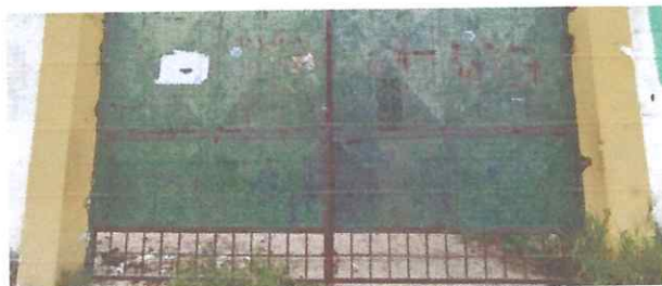
Foto: 1, Sustitucion de porton de metal por porton corredizo.
