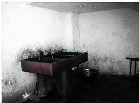
Foto 3: Remoción de pila y drenaje de abastecimiento de agua potable.
