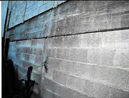
Foto 2: Repello y cernido + Impermeabilizado de pared posterior de escuela.
