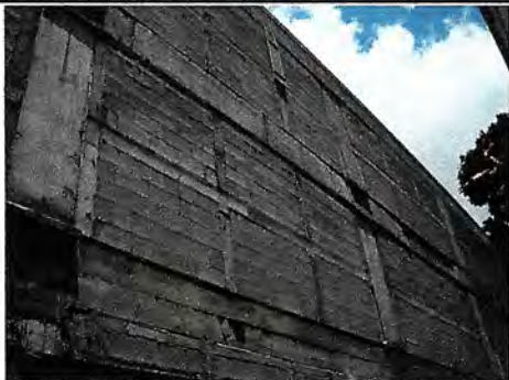
Foto 1: Repello y cernido + Impermeabilizado de pared posterior, derecha e izquierda de escuela.
