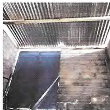
Foto 10: Obra gris en cocina
