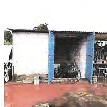
Foto 12: Techo de descanso de gradas y cocina
