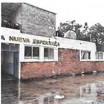
Foto 15: Fachada y obra gris en segundo nivel
