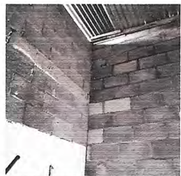
Foto 11: Techo de descanso de gradas y cocina
