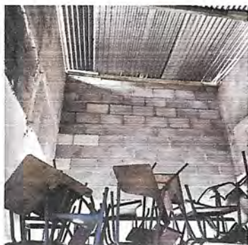
Foto 9: Obra gris en cocina
