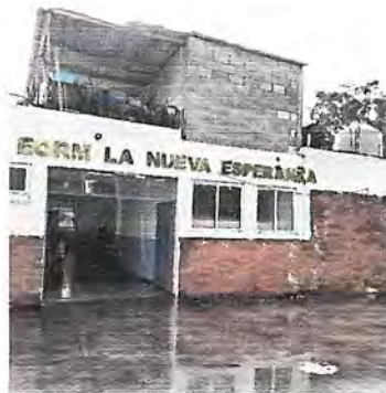
Foto 14: Fachada y obra gris en segundo nivel
