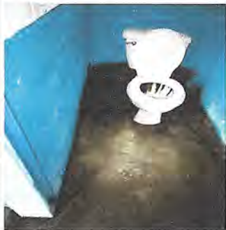
Foto 1 Sustitución de unidades de servicios sanitarios en módulos de sanitarios de niñas.
