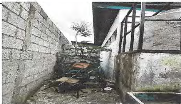
Foto 3: Cubierta de lamina y estructura metalica en un area de 35.00m2 para implementacion de bodega.
