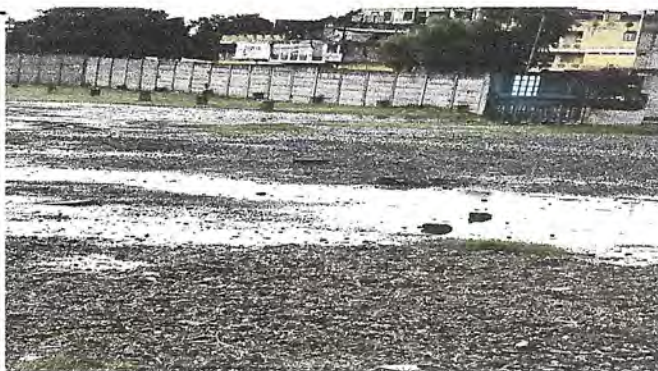
Foto 4: Cubierta de lamina tramo de camino de alumnos.
