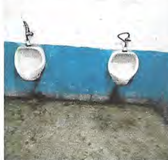
Foto 2: Sustitución de unidades de servicios sanitarios en módulos de sanitarios de niños.
