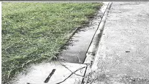
Foto 5: Cubierta de concreto para toda la cuneta existente.
