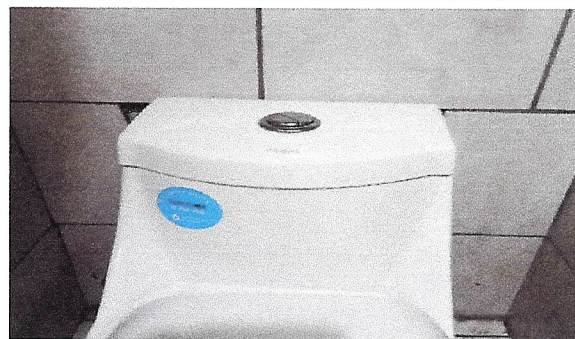
Foto 2: Reparación de accesorios de sanitarios
