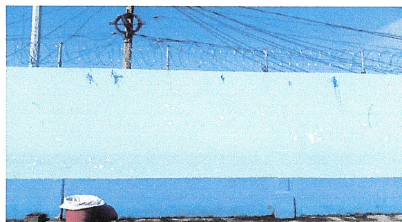
Foto 10: Pintura en muros exteriores.
