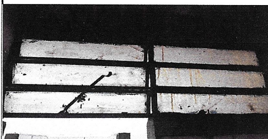
Foto 6: Sustrucción de ventanas a PVC en sanitarios.
