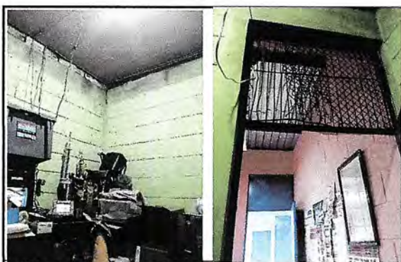
Foto 5: Puerta y pintura de bodega
