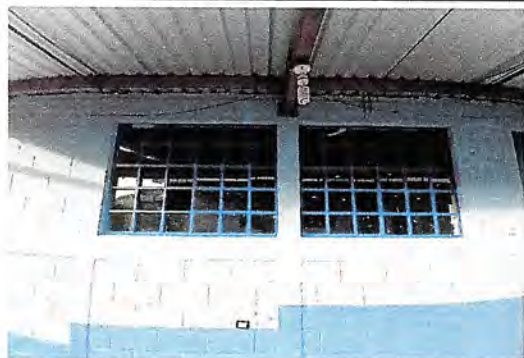
Foto 1: 2 Ventanas aula de preprimaria sin entrada de aire. 1.24 x 1.62 y 1.24 x 1.56 m2
