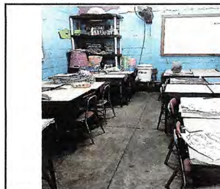
Foto 2: Piso de cemento en aula de párvulos
