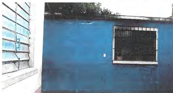
Foto 5: Techo para cubrir pila de la cocina
