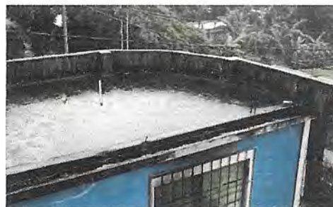
Foto 2: Bajada de agua Hinabilitada
