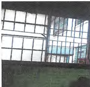
Foto 5: Sustitución de Ventana a PVC
