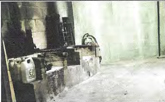
Foto 3: Sustitución de Piso antideslizante
