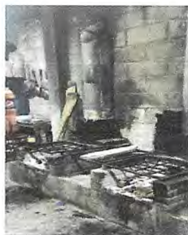
Foto 5: Sustitución de salida de humo
