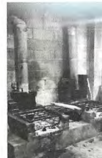
Foto 4: Colocación de fachaleta para mejor mantenimiento
