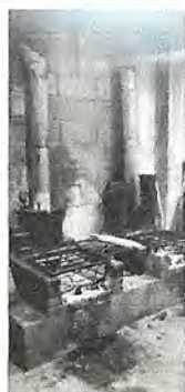
Foto 3: Instalación de una Campana para salida de humo
