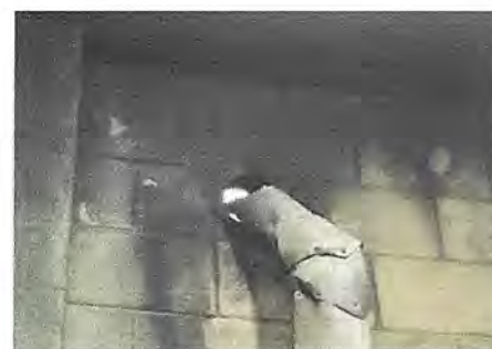
Foto 4: Salida del humo quebrada
