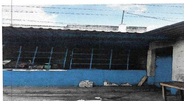
Foto 1 Cocina: Cubierta de lamina, estructura de techo, canales y bajadas de agua,
