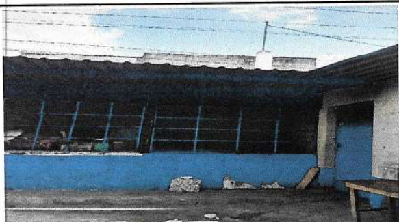
Foto 5 Cocina: Reparación y cambio de puerta de cocina Reparación de área de cocina y reparación de sistema eléctrico
