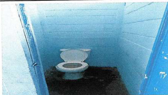
Foto 2 Servicio Sanitarios y Accesorios: Sustitución de sanitarios en mal estado en área de niños y niñas
