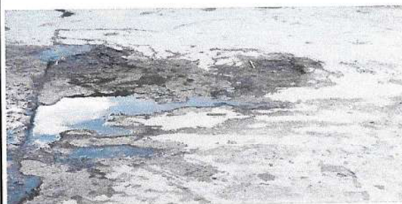
Foto 6 Cuneta: Sustitución de cuneta de concreto
