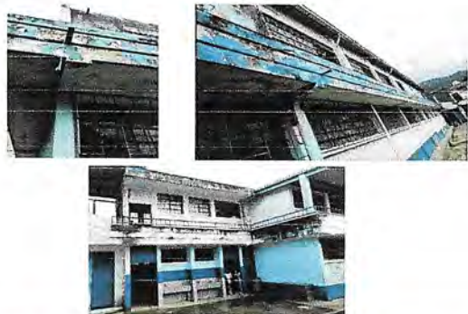
Foto1: REPARACIÓN DE REPELLO Y CERNIDO EN PAREDES
