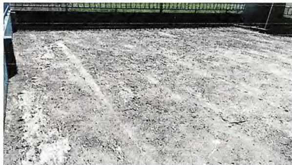
Foto 2: LEVANTAMIENTO DE PIEZCLÓN REPARACIÓN DE LOSA
