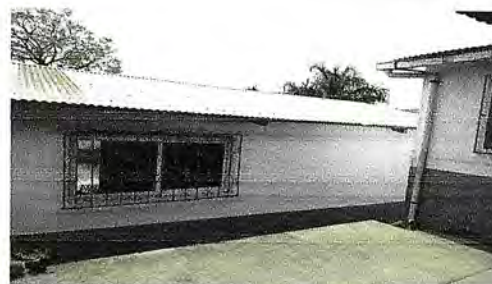
Foto 4: cubierta de lámina modulo 2
