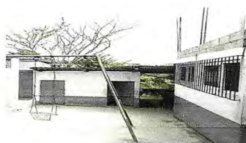
Foto 6: estructura de techo
