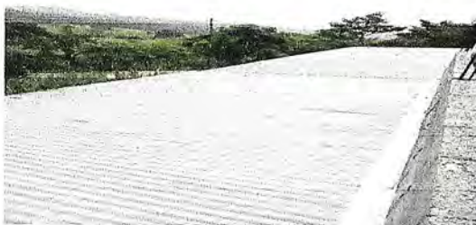
Foto 3: cubierta de lámina modulo 1
