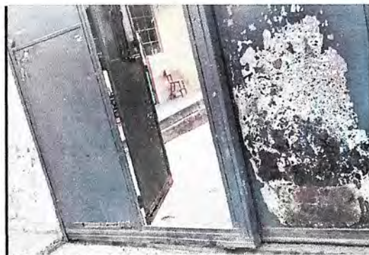
Foto 5: Parte de abajo del portón en mal estado.
