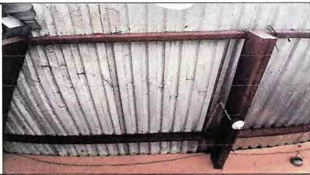
Foto 3: Lámina de corredor frente a aulas y dirección
