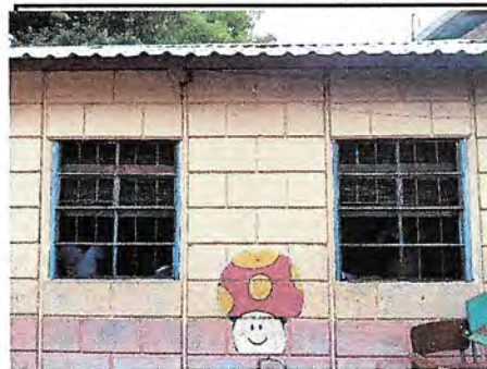
Foto 6: Ventanas de 1 x 1 metro
