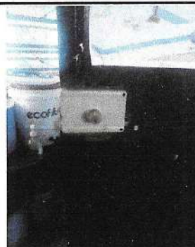
Foto 6: instalacion de chapa en los salones
