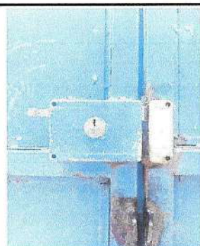
Foto 5: Cambio de chapa del portón principal, ajuste de tornillos y soldaduras, aplicación de dos manos de pintura tipo esmalte o poliuretánica, según exposición a la interperie
