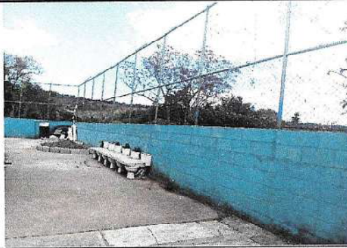
Foto 4: asi mismo cada una llevará una zapata de 0.60 x 0.60. terminado de muro sisado sobre el muro existente con un agregado de 140.00 m2
