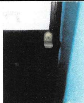
Foto 4: instalacion de chapa en los salones
