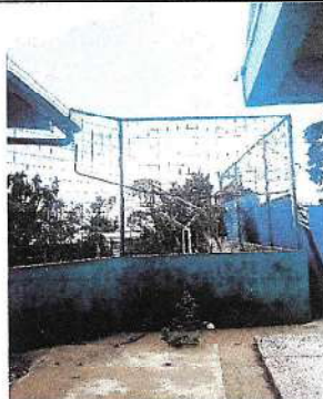
Foto 2: reparacion de muro perimetral
