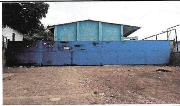
Foto 6: implementación de muro como soporte para el portón principal de metal, cubierta de lámina instalación de estructura para cubierta del portón principal de ingreso, reparación de sistema electrico de timbre
