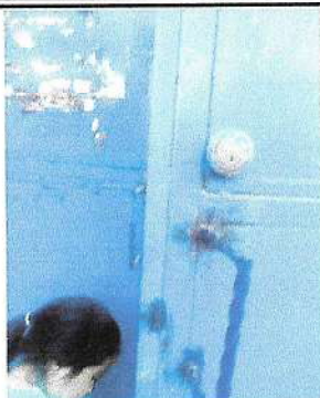
Foto1: Mantenimiento a Porton metalico de 4.00x 2.40 mts como reparacion de deformaciones, corrosión o desgaste en visagras, rieles y metal mismo de cierre
