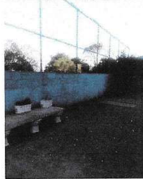
Foto 2: complemento de 25 columnas de 0.20x0.20 y altura de 2.80 mts de alto
