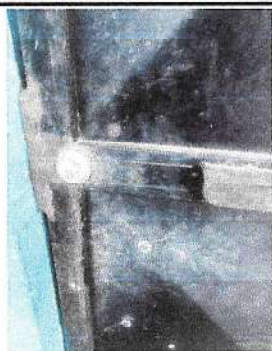
Foto 3: instalacion de chapa en los salones
