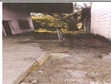
Foto 6: CANALES Y BAJADAS DE AGUA PLUVIAL instalación de 3.00m de canal en cocina con canal americano c26 0.54X3.0m y 1 bajadas de agua pluvial con tubo de 3" con una altura de de 3.00m.
