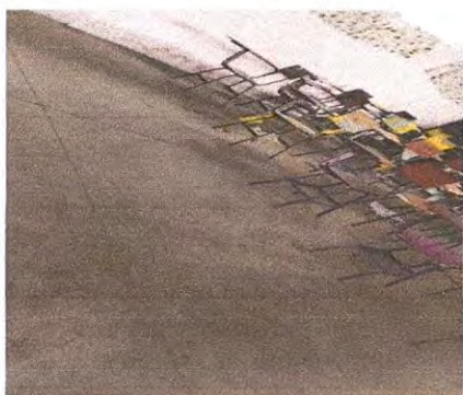
Foto 3: PISO Sustitución de piso en área de aula de preprimaria con dimensiones de 6.00m X 6.00m con un área de 36m2
