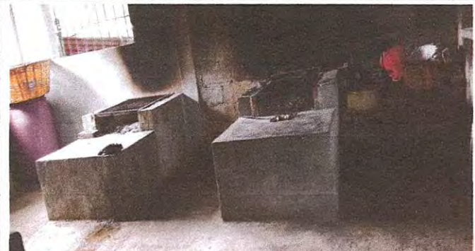
Foto 4: REPARACIÓN O SUSTITUCIÓN DE ÁREA DE COCINA instalación de tubo de concreto de 10" en salidas de humo de planchas artesanales.
