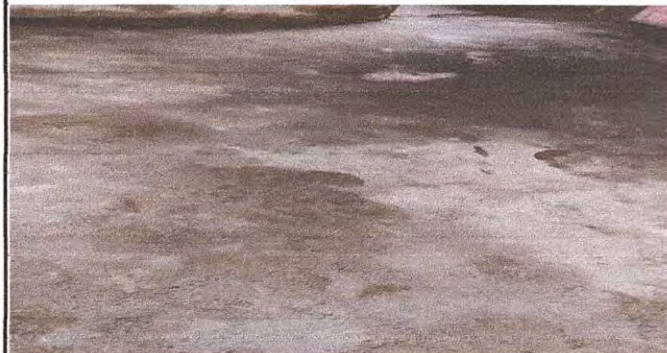
Foto 2: PISO (Sustitución de 30m2 de piso en mal estado en cocina por piso cerámico lake mate 33X33).
