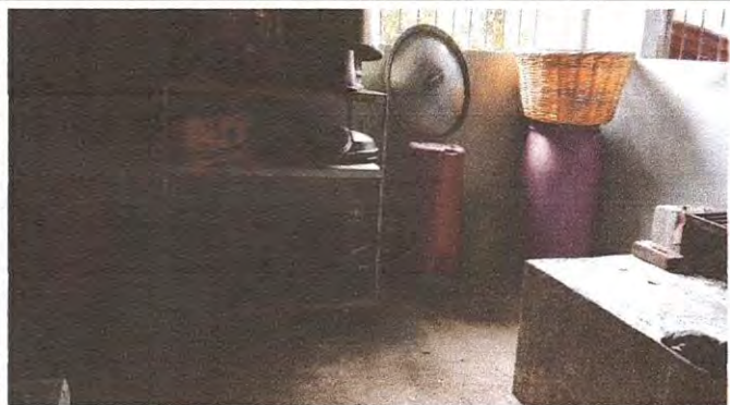
Foto 1: REPARACIÓN O SUSTITUCIÓN DE ÁREA DE COCINA instalación de azulejo natural mate a una altura de 1.60m. Mesa de concreto con dimensiones de 2.40 metros lineales X 0.60m de profundidad X 1.00m de altura con 3 divisiones y con puertas de pvc en cada una de sus divisiones abatibles serie 60
