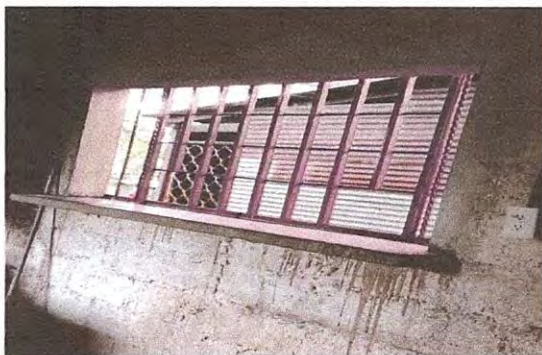
Foto 3: REPARACIÓN O SUSTITUCIÓN DE ÁREA DE COCINA Instalación de persiana prefabricada de aluminio en espacio de recepción de alimentos con dimensiones de 0.85m de ancho X 1.80m de altura,
