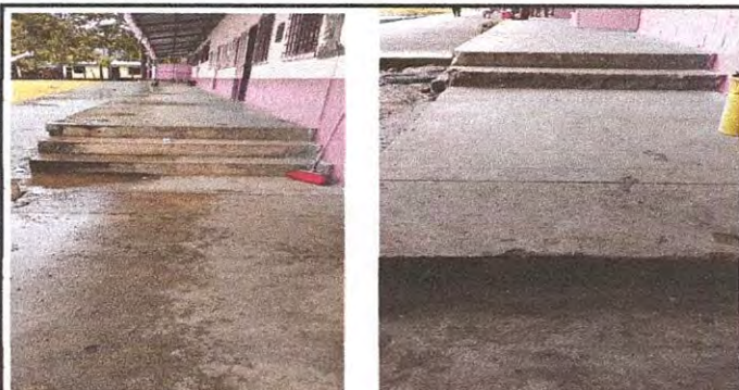
Foto 6: LOSA DE PATIO instalación de 3 rampas en área de gradas con dirección a cocina con dimensiones 1.20m ancho X largo 2.50m con su
