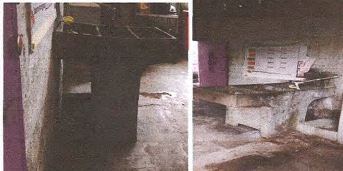
Foto 6: REPARACIÓN O SUSTITUCIÓN DE ÁREA DE COCINA instalación de 1 pila artesanal en cocina con dimensiones 1.40m largo X 1.20m ancho X 1.30m altura con dos lavaderos fundida en su totalidad y acabada con azulejo blanco de 25X33cm color blanco, su respectiva tubería
