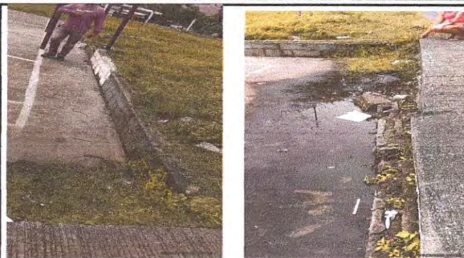
Foto 3: CERCO O MURO PERIMETRAL (Reparación de muro perimetral ubicado en cancha polideportiva)
