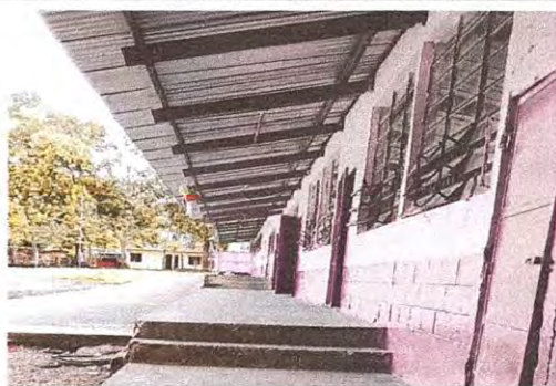
Foto 5: CANALES Y BAJADAS DE AGUA PLUVIAL CANALES Y BAJADAS DE AGUA PLUVIAL (Instalación de 30 metros lineales de canal de agua pluvial en aulas con canal americano c26 0.54X3.0m, instalación de 5 bajadas de agua pluvial con una altura de 3.00m en modulo de aulas,
