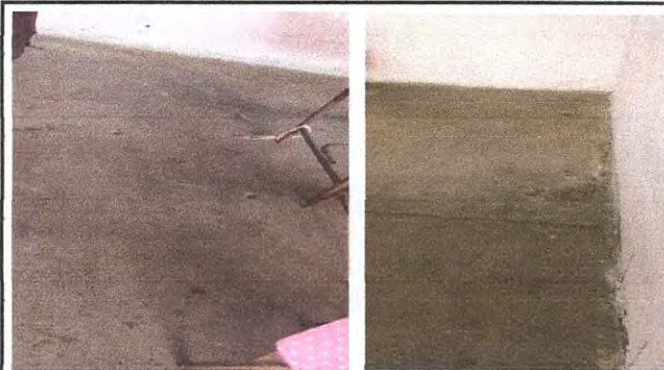
Foto 4: PISO aula de primaria con dimensiones de 6.00m X 6.00m con un área de 36m2
