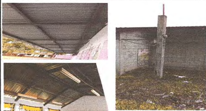
Foto1: REPARACIÓN DE SISTEMA ELÉCTRICO (Reparación de sistema eléctrico en dos aulas, 2 bodegas, dirección, y laboratorio de computación que consiste en sustitución 34 unidades de iluminación, 27 tomacorrientes, 12 interruptores simples, caja de circuitos y flipones.)
