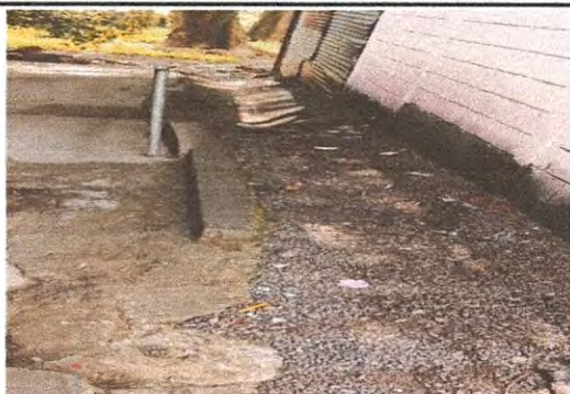
Foto 5: LOSA DE PATIO Sustitución de losa de patio con un área de 10m2 con un espesor de 8cm y con resistencia 4000
