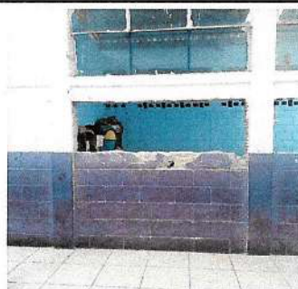
Foto 3: REPARACION DE VANOS DE VENTANAS, E INSTALACION DE VENTANAS
