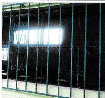
Foto 4: SUSTITUCION DE VENTANA EN AREA DE SALON
