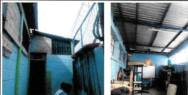
Foto 1: INSTALACION DE ESTRUCTURA DE TECHO Y LAMINA TROQUELADA EN PATIO DE COCINA, 2; SUSTITUTUCION DE LAMINAS DEL FONDO EN SALONES DE CLASES.
