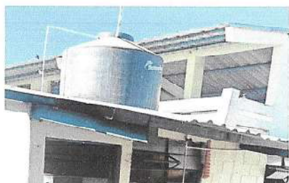
Foto 3: Reparación y mantenimiento de depósito de agua
