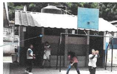
Foto 4: Mantenimiento de ventanal de baños y sustitución de vidrios faltantes.
