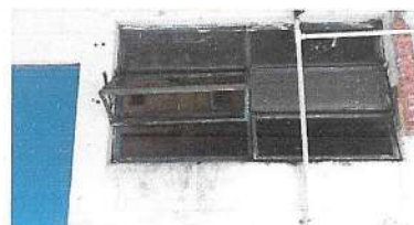
Foto 6: Mantenimiento de ventanal de baños y sustitución de vidrios faltantes.
