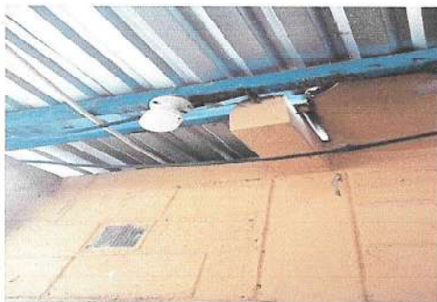
Foto1: Cubierta de Lamina, sanitarios de varones, cambio de laminas para evitar la filtración de agua.
