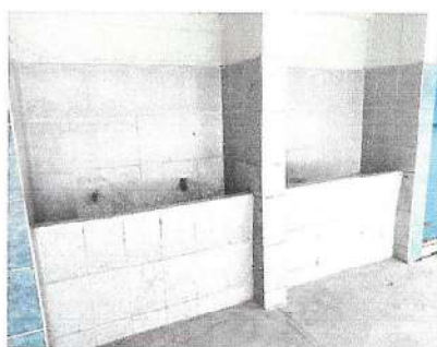
Foto 5: Mantenimiento y habilitar los chorro para la fusión de lavamanos
