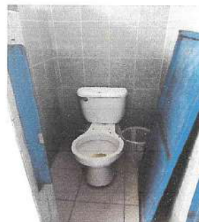
Foto 4: Reparación de puerta de baño, colocación de la puerta y mantenimiento de la misma.
