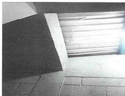
Foto 1: Impermeabilización de losa baños maestros
