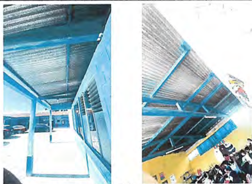
Foto 1: SUSTITUCION DE CUBIERTA DE LAMINA Y MANTENIMIENTO DE ESTRUCTURA, AREA DE SALON DE TERCERO PRIMARIA.
