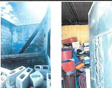
Foto 5: FUNDICION DE BASE PARA PISO EN AREA DE PILAS E IMPLEMENTACION FOSA PARA DRENAJE DE PILA.
