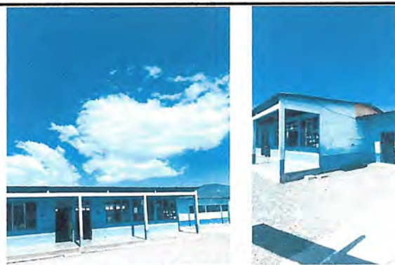
Foto 6: INSTALACION DE PISO EN AREA SALON DE PREPRIMARIA.
