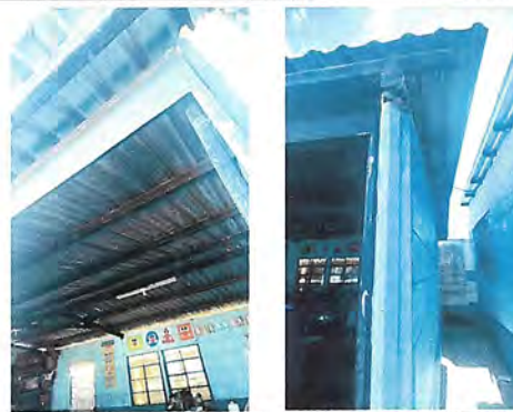
Foto 2: SUSTITUCION DE CUBIERTA DE LAMINA Y MANTENIMIENTO DE ESTRUCTURA, AREA DE SALON DE PREPRIMARIA
