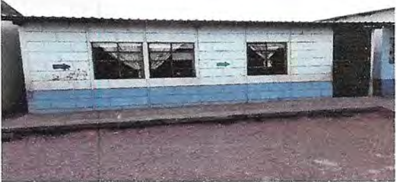
Foto 6: Sustitución de 3 ventanas en mal estado de preprimaria por ventanas de PVC.
