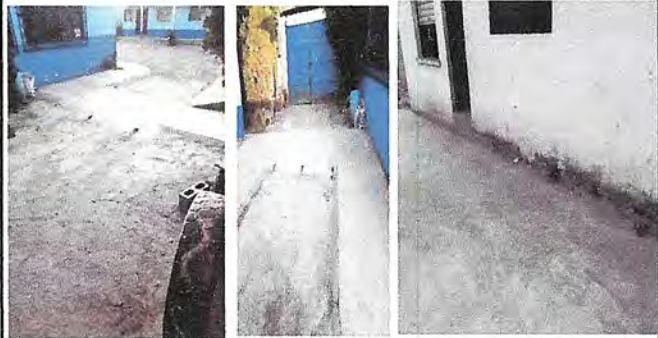
Foto1: Sustitución de 56 m2 de losa de patio en mal estado en ingreso al establecimiento incluyendo rampa. Banqueta en área de cocina.
