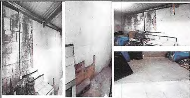
Foto 3: Creación de gabinete aereo fundido en la misma ubicación de mesa de concreto, mesa de concreto con tres divisiones para dar continuidad a mesa existente. Sustitución de 20m2 de piso
