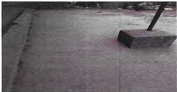
Foto 5: Instalación de 20m lineales de concreto con rejilla.
