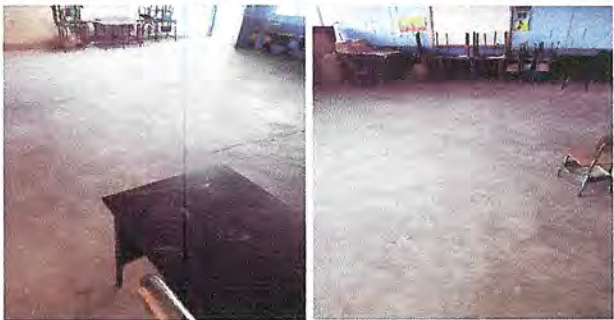
Foto 4: Instalación de piso cerámico en dos aulas conformando un área de 120m2.
