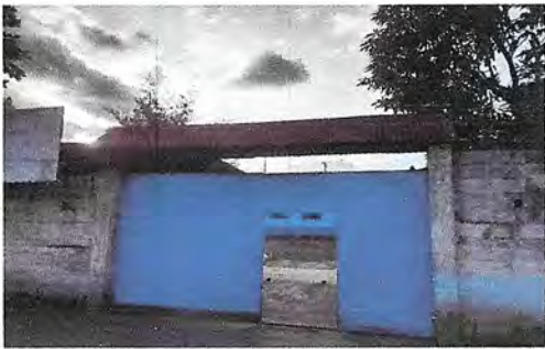
Foto 2: Corrección de altura de portón
