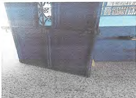
Foto 7 PUERTAS (mantenimiento de 7 puertas y el portón principal; lijado, pintado a dos manos y reajuste de niveles)
