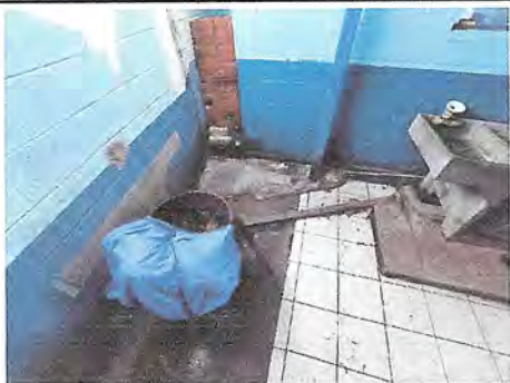
Foto 3: REPARACIÓN DE RED DE DRENAJES Y RED DE AGUA POTABLE (Reparación de área de área de pila, sustitución tubería en mal estado con una longitud de 7.50 mts con tubería de 6 pulg. + implementación de
