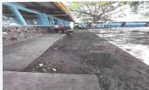
Foto 4: CUNETA DE CONCRETO (Implementación de cuneta de concreto con piezas prefabricada, o en su defecto con tubo de 13pulgadas partido a la mitad, + bordillo y base fundida para una longitud de 31mts. +
