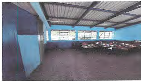
Foto 6: REPARACIÓN DE REPELLO Y CERNIDO DE PAREDES (Sustitución de pared provisional por pared formal de block, en área de salón de clase, con 4 columnas de 0.15x 0.20 de 4 hierros de 3/8 y estribos a cada
