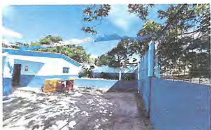
Foto 1: CUBIERTA DE LÁMINA (Instalación de cubierta de lámina en área de ingreso principal con medidas de 10.50x5.50, iniciando desde módulo salones principal hasta delimitar los 10.50 mts + instalación de cubiera en
