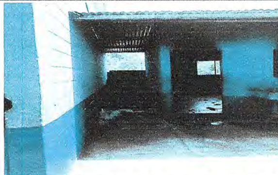
Foto 4: colocación de hiladas de block en bodega y colocación de puerta de metal
