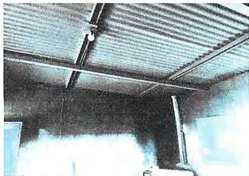
Foto 1: sustitución de techo y estructura en cocina, reparación de sistema eléctrico
