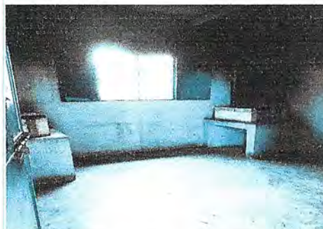
Foto 2: Colocación de piso en cocina, sustitución de planchas e implementación de gabinetes y reparación de puerta y ventana
