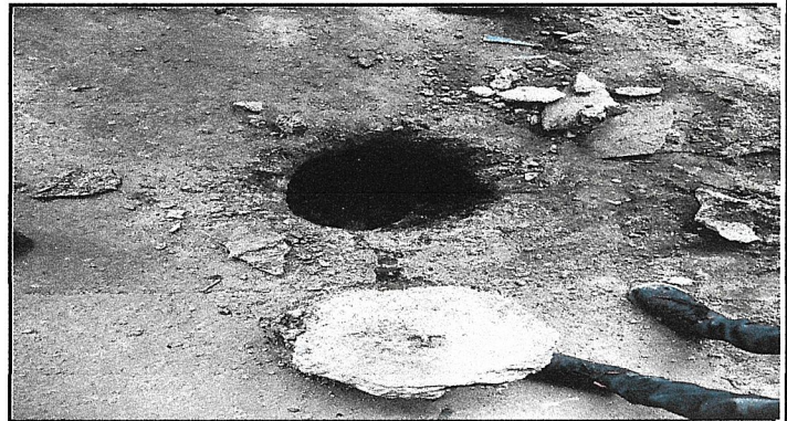
Foto 4: EXTRACCIÓN DE DESECHOS DE FOSA SEPTICA
