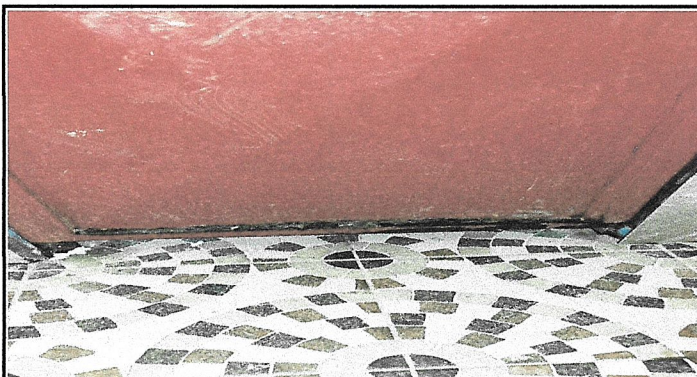
Foto 3: CAMBIO DE 8 PUERTAS DE SANITARIOS
