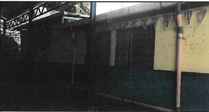
Foto 5: CAMBIO DE DRENAJE DE AGUA PLUVIAL
