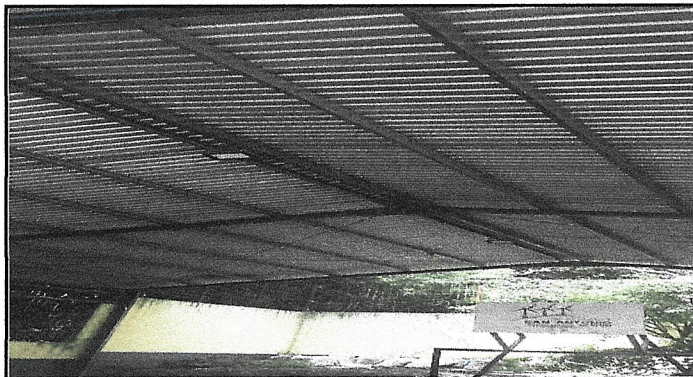
Foto 4: CAMBIO DE LUMINARIAS DE TECHO DE CANCHA POLIDEPORTIVA
