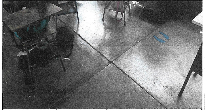
Foto 2: INSTALACIÓN DE PISO CERMÁMICO EN 5 SALONES DE CLASE
