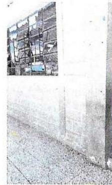
Foto 4: Pintura de paredes de exteriores
