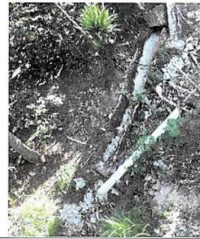
Foto 2: Reparación de drenaje de aguas pluviales
