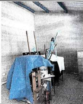
Foto 5: Pintura de paredes de interiores.
