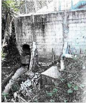
Foto 1: Reparación de drenaje de aguas pluviales
