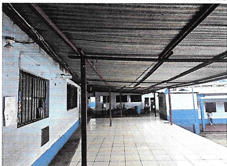
Foto 5: Cambio de láminas de 533 mts.2 por levantamiento de pared
