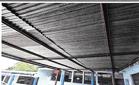
Foto 4: Mantenimiento a la estructura metálica lijado y pintado.
