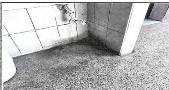
Foto 7: Servicios Sanitarios y sus Accesorios Cambio de Accesorios de lavamanos
