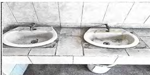
Foto 8: Servicios Sanitarios y sus Accesorios Cambio de Accesorios de lavamanos
