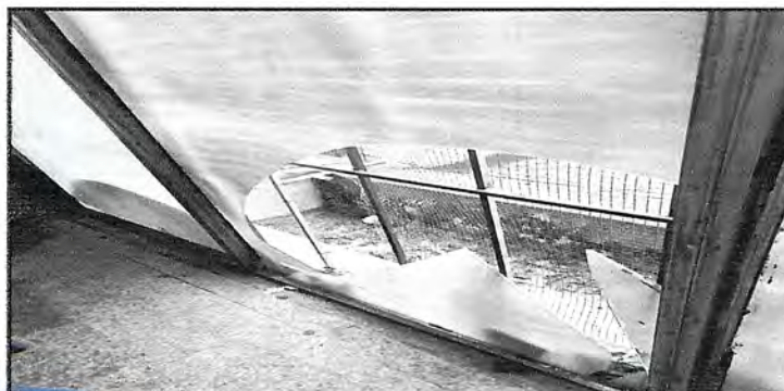
Foto 12: Ventanas Sustitución de vidrios en mal estado de 3 ventanas existentes de salón de segundo nivel continuo a modulo de gradas, y mantenimiento limpieza de
