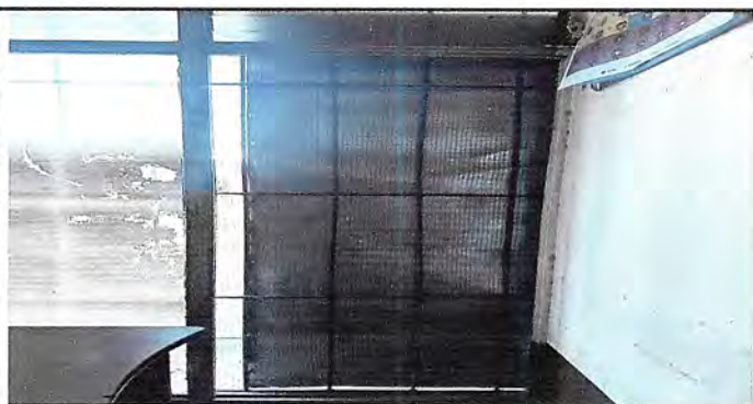
Foto 13: Ventanas Suministro e instalación de ventanas de PVC de primera calidad, color blanco (5.61 x 0.57 mts)
