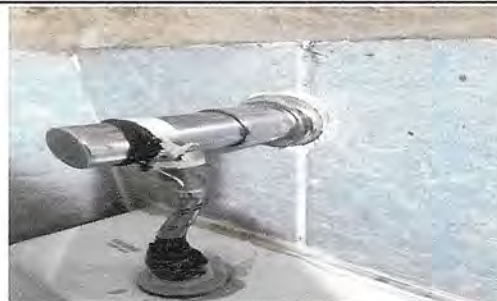
Foto 2: Servicios Sanitarios y sus Accesorios Sustitución de valvul de push par mingitorio marca Richford
