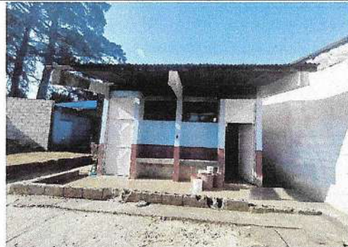
Foto 2: Sustrucción de cubierta de lamina y estructura de modulo de baños.
