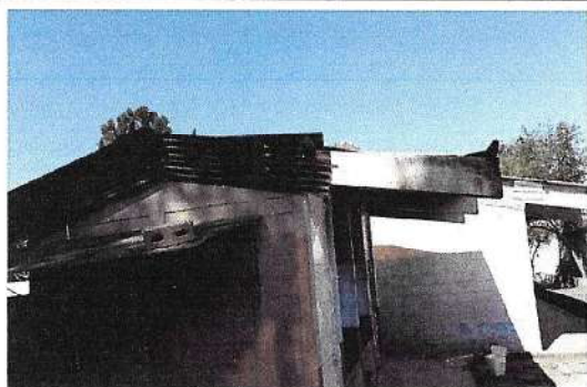
Foto 1: Sustrucción de cubierta de lamina y estructura de modulo de baños.
