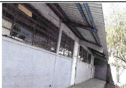
Foto 5: Pintura de en exterior e interior de modulo de salones+ instalacion de canal metalico y bajantes pluviales en modulo de salones.
