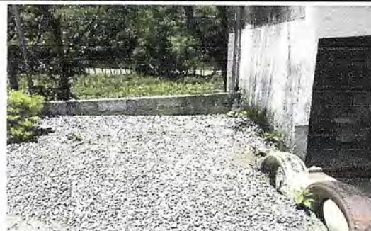
Foto 2: AREA DE AMPLIACIÓN PARA SANITARIOS
