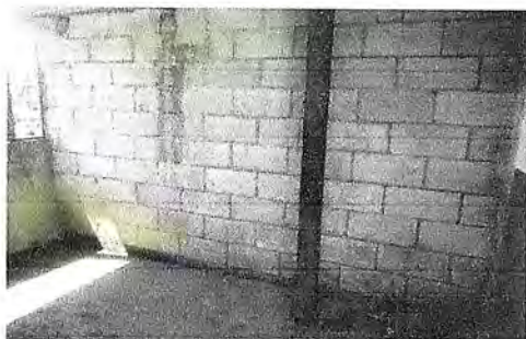
Foto 5: REPELLO DE PARED Y SE ABRIRÁ PARA UNA VENTANA
