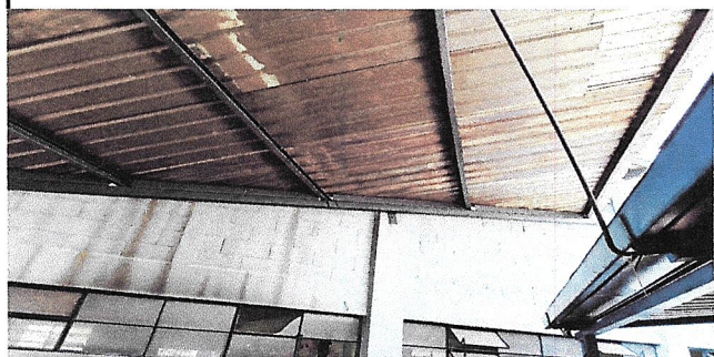
Foto 1: Cambio de estructura de techo en la cocina.
