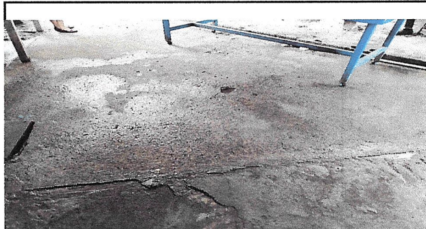
Foto 2: Cambio de piso cerámico antideslizante en toda la cocina y fundición de contrapiso.
